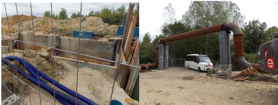
Zone de pompages
