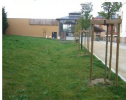
Noue engazonnée végétalisée
